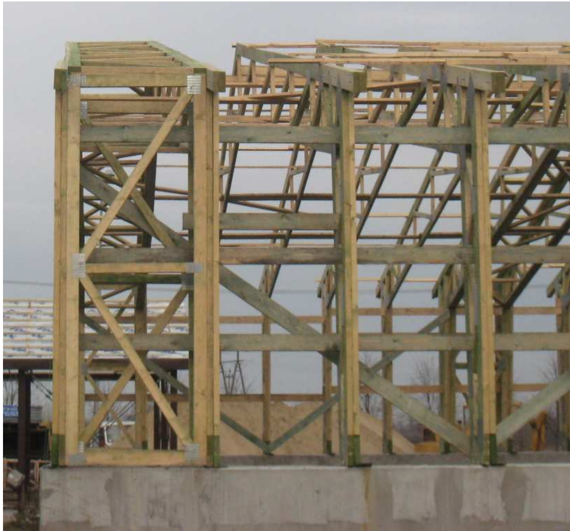
RAMA KRATOWNICOWA – GŁÓWNY UKŁAD NOŚNY
