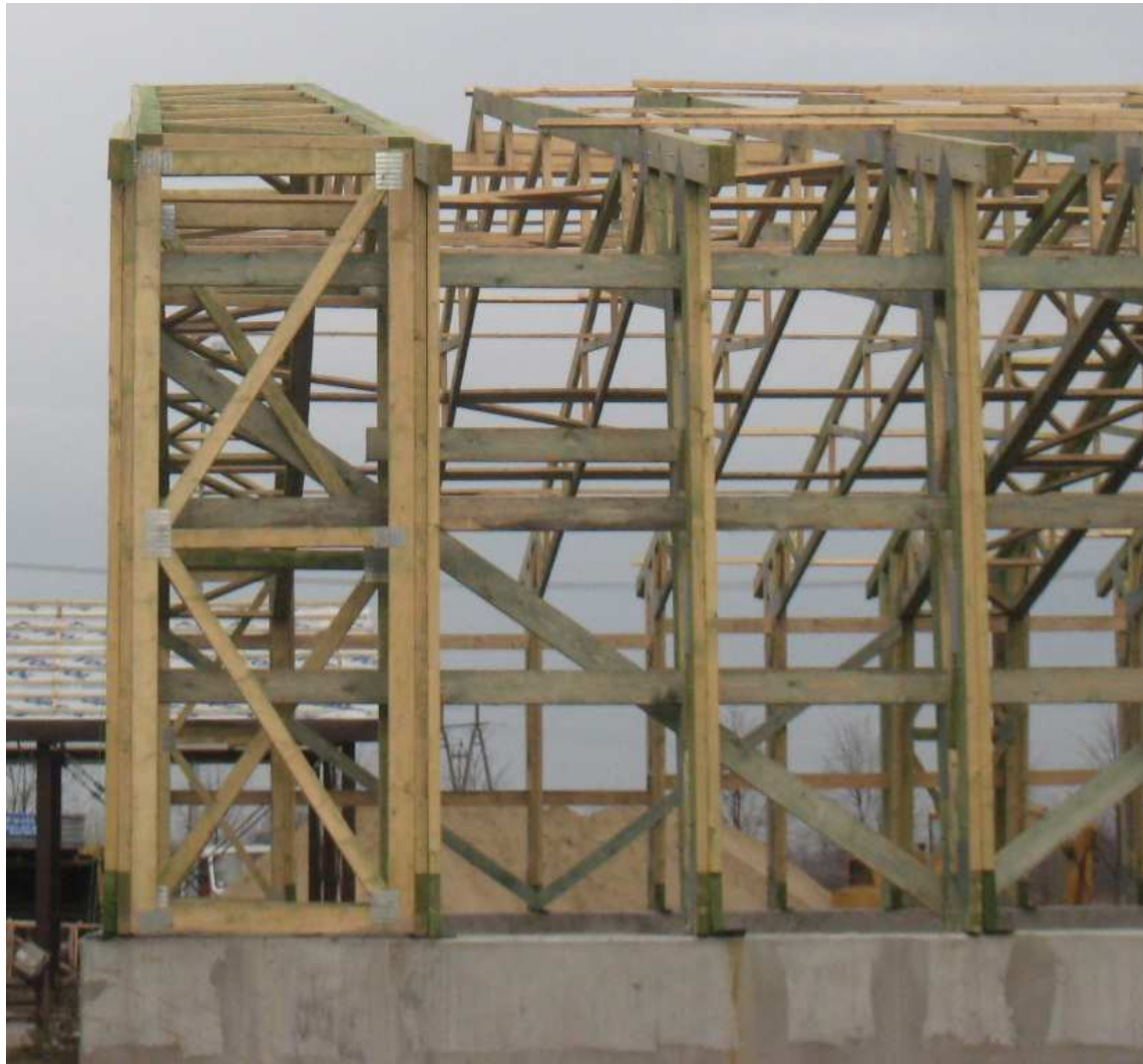
RAMA KRATOWNICOWA – GŁÓWNY UKŁAD NOŚNY
